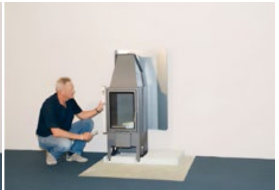
Kamineinsatz mit Wasserwaage einrichten
