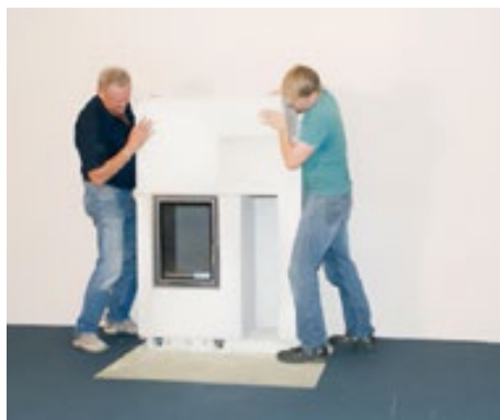
Verkleidungselemente Stück für Stück zusammensetzen und verkleben
