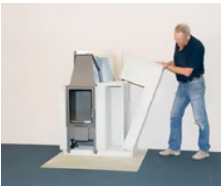
Verkleidungselemente Stück für Stück zusammensetzen und verkleben
