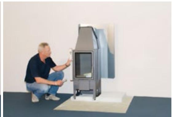
Kamineinsatz mit Wasserwaage einrichten
