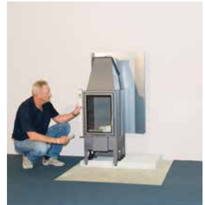
Kamineinsatz mit Wasserwaage einrichten
