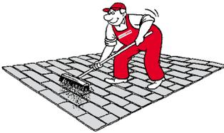
Betonpflaster und -platten sind nach DIN 18318 mit Fugenbreiten von mindestens 3 mm zu verlegen, denn die Fuge ist entscheidend für die statische Erhaltung der Pflasterdecke. Die Einhaltung der vorgegebenen Fugenbreite und die nachfolgende genügende Einschlämmung verhindern Beschädigungen von Pflaster und Platten während der Verdichtung der Pflasterdecke und während ihrer Benutzung. Abstandhalter sind kein Ersatz für das vorgeschriebene Fugenmaß.
