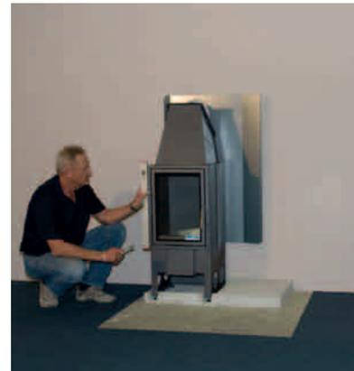
Kamineinsatz mit Wasserwaage einrichten
