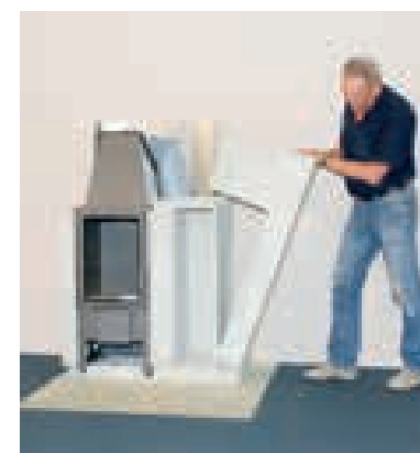
Verkleidungselemente Stück für Stück zusammensetzen und verkleben
