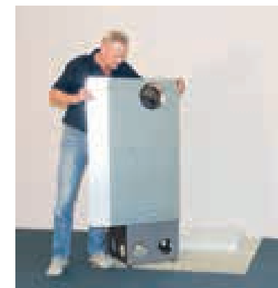
Wärmeschutzblech (Zubehör) montieren
