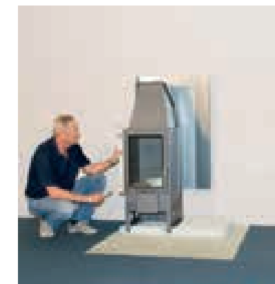
Kamineinsatz mit Wasserwaage einrichten
